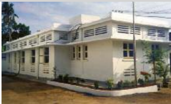
The Renovated leprosy ward. Khoa Phong cũ sau sửa chữa.
